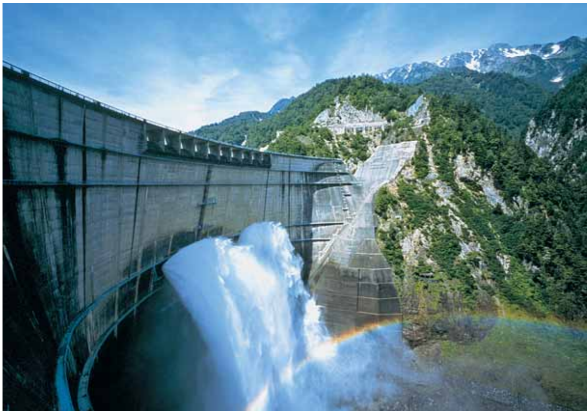
Barrage de Kurobe.
